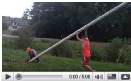
MONTAŻ KOMPOZYTOWYCH SŁUPÓW TELETECHNICZNYCH
