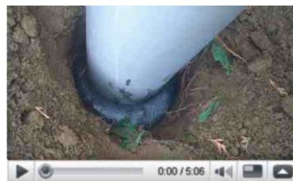
MONTAŻ KOMPOZYTOWYCH SŁUPÓW TELETECHNICZNYCH
