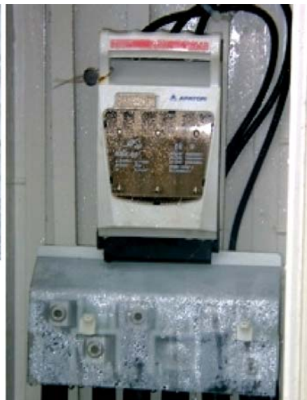
Rys. 1. Zjawisko kondensacji w obudowie: na powierzchni obudowy (z lewej) oraz na powierzchni aparatów
